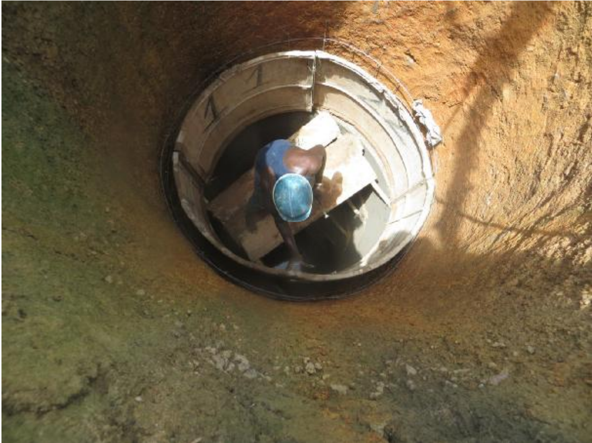
Arbeid i brønn i Samabu etter utgraving.
