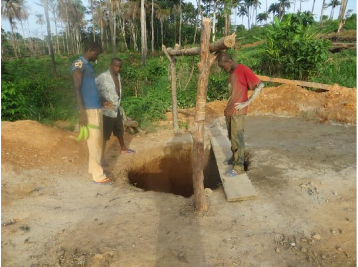
Bygging av ny brønn i landsbyen Seinga i Dea.
