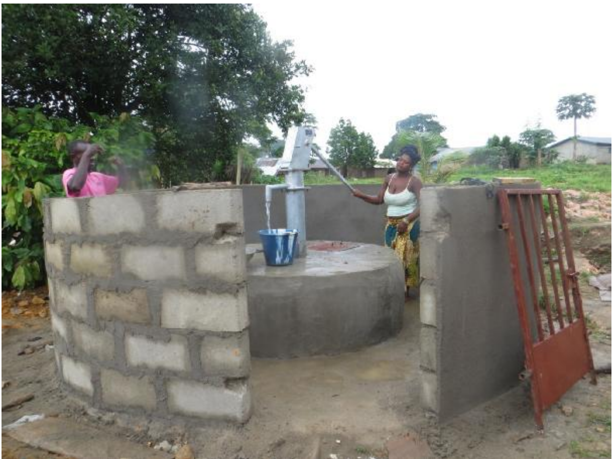
En beboer i Baoma landsby tester den nylig installerte håndpumpen på en helt ny brønn for å sikre at den fungerer som den skal.
